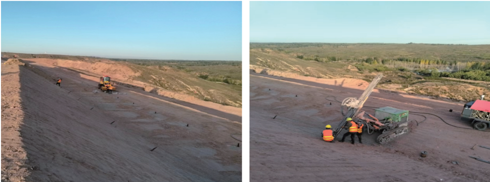
图 4 打孔注浆施工
