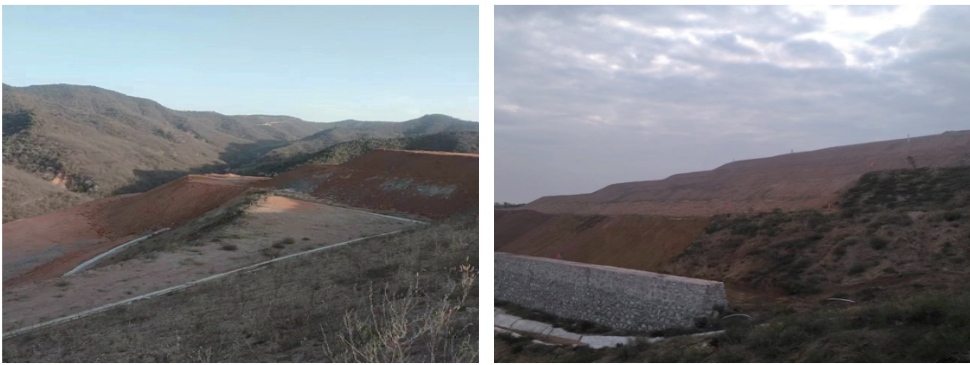
图 5 黄土覆盖、台阶式整地
